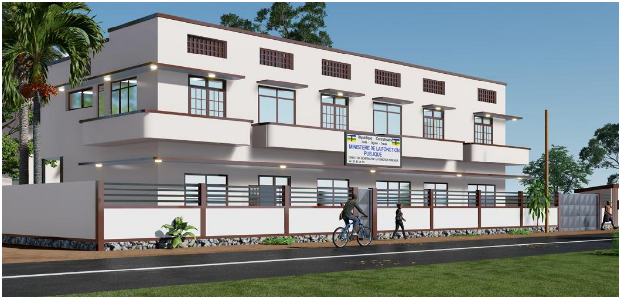
Image 2 : Vue de côté droit du bâtiment réhabilité
